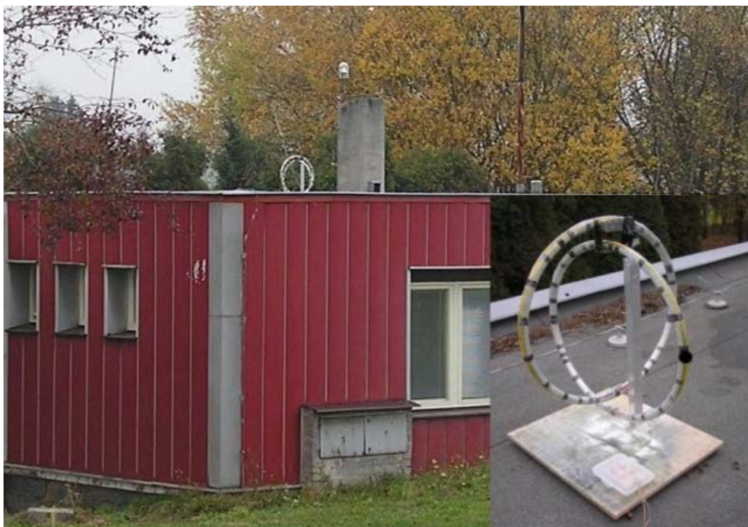
Obr. 1: Magnetické antény na střeše provozní budovy ionosférické observatoře v Panské Vsi.
